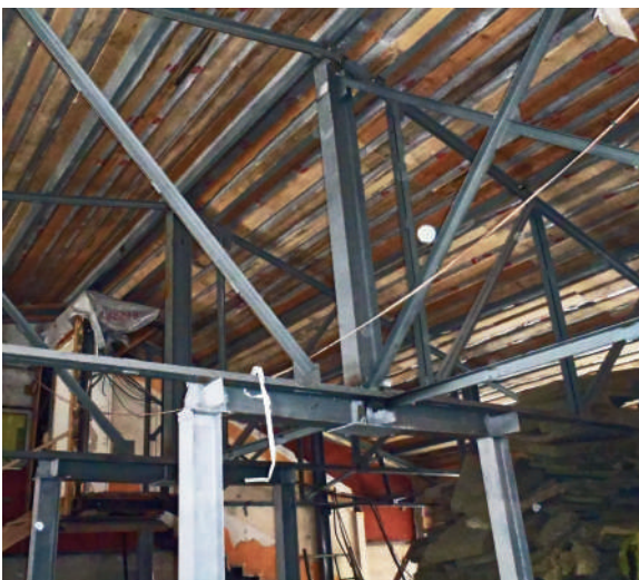
▲ Обследование строительных конструкций
