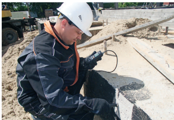
▲ Неразрушающий контроль прочности бетона ударно импульсным методом Ониск 2.6
