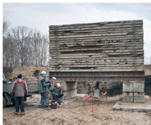
▲ Испытания свай с использованием грузовых платформ
