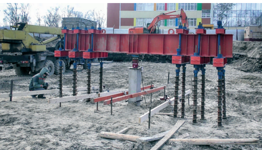
▲ Установка для испытан- ия свай с использо- ванием анкерных свай
