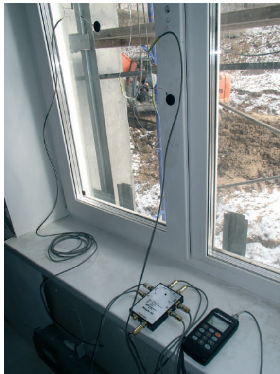
▲ Измерение наружных ограждающих конструкций теплогофром
