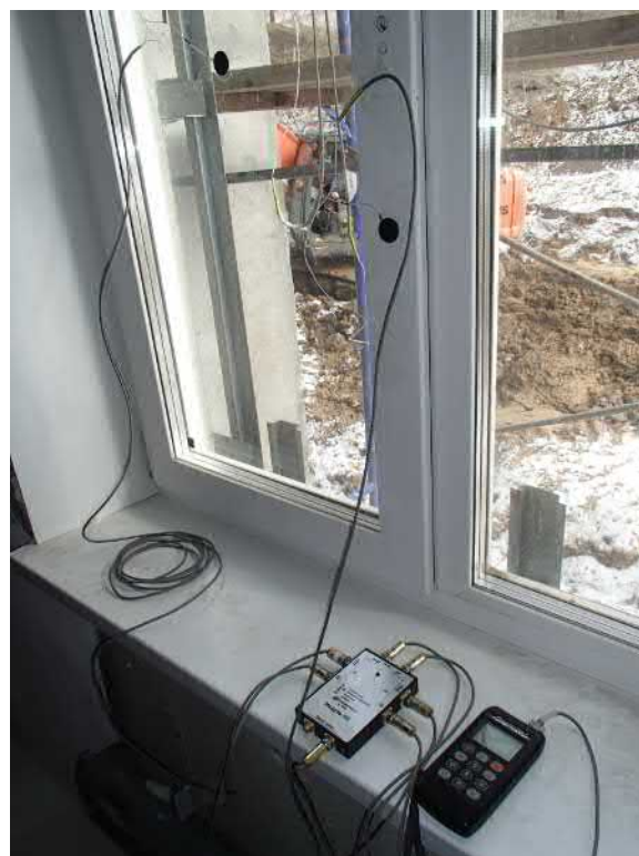
▲ Измерение наружных ограждающих конструкций теплогографом
