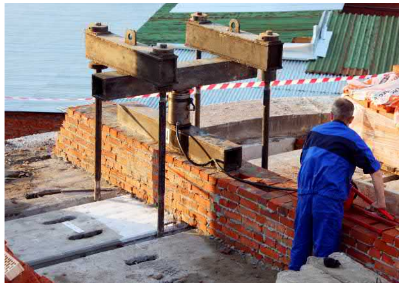
▲ Испытание конструкций в натурных условиях
