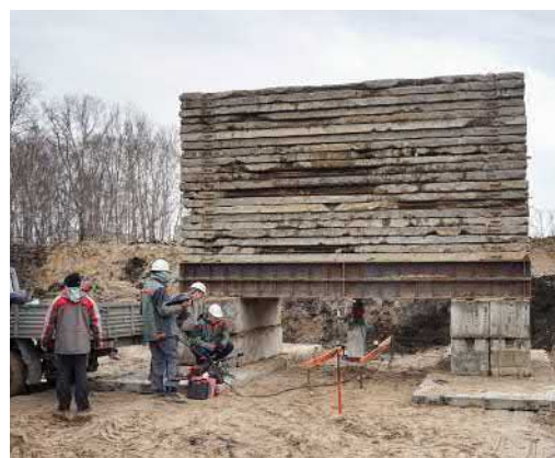
▲ Испытания свай с использованием грузовых платформ
