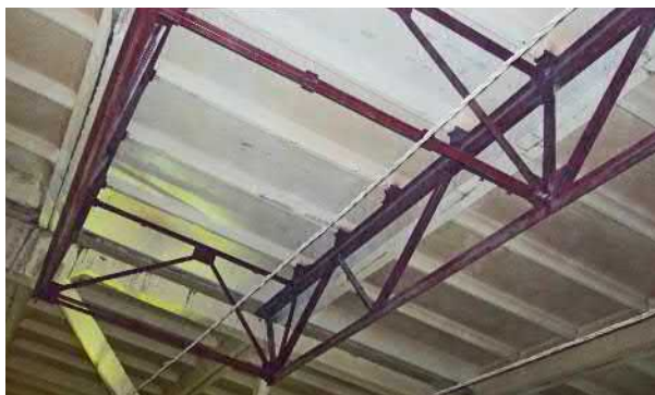
▲ Усиление покрытия. Реализация
