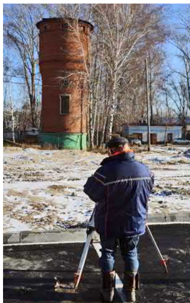
▲ Наблюдения за деформациями фундаментной плиты
