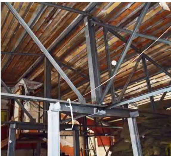
▲ Обследование строительных конструкций
