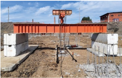
Испытание на выдёргивание
