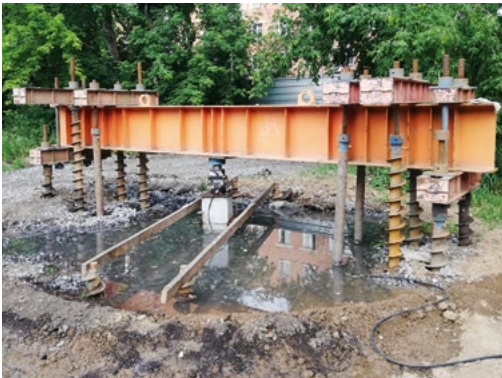
Испытание свай с замачиванием грунтов
